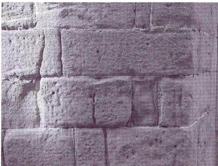
FIGURA 16: Mur d'una torre del capdamunt de la baixada de l'Eraime (Vic)
